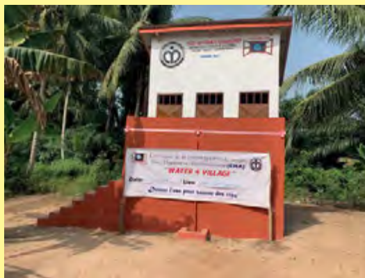
Bild oben: Ein Latrinenblock mit 3 Toiletten
